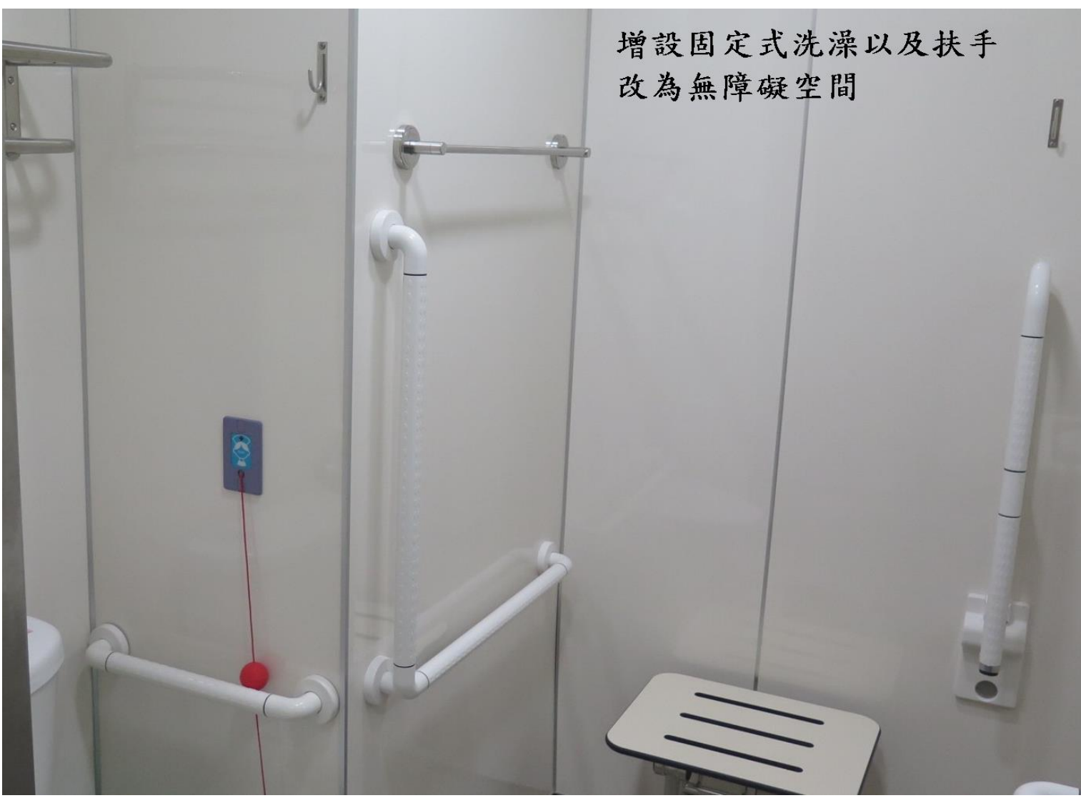
圖四、廁所工程改建
